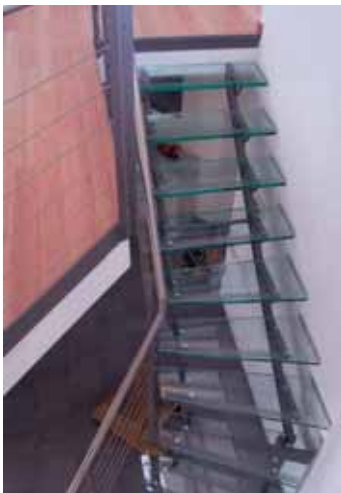
Metalltreppe mit Glas
