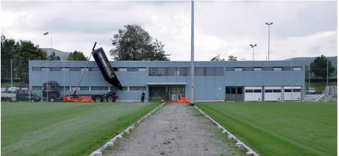
Das neue Garderobengebäude steht bald zur Verfügung.
